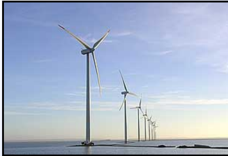
Installation d'éoliennes en mer : première installation à Veulettes sur mer
